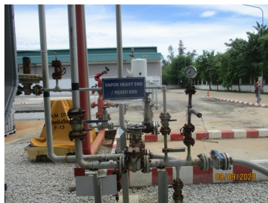
รูปที่ 45 อุปกรณ์ตรวจสอบการรั่วไหล ที่แนวท่อขนส่ง
