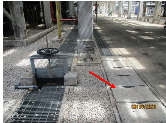
รูปที่ 15 รางระบายน้ำฝนที่แยกออกจากรางระบายน้ำของกระบวนการผลิต
