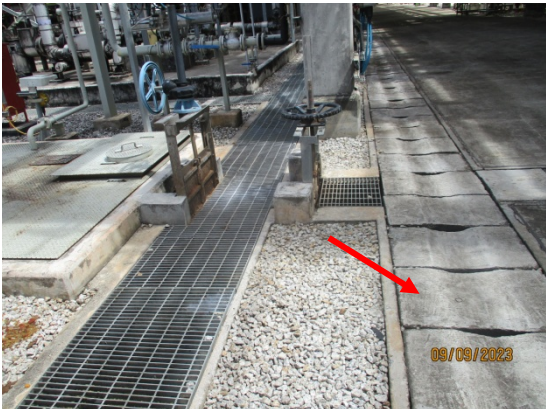
รูปที่ 15 รางระบายน้ำฝนที่แยกออกจากรางระบายน้ำของกระบวนการผลิต
