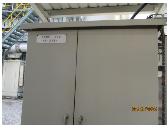
รูปที่ 4 ระบบ CEMS RTO หน่วยที่ 1 และหน่วยที่ 2
