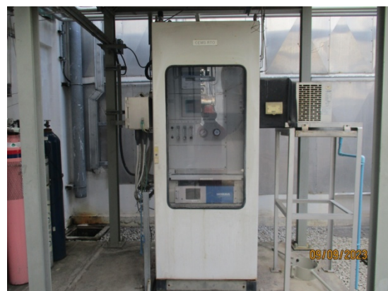
รูปที่ 4 ระบบ CEMS RTO หน่วยที่ 1 และหน่วยที่ 2
