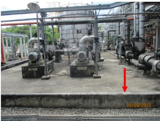
รูปที่ 42 คันกั้นบริเวณเครื่องสูบลำสายสารเคมี
