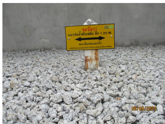
รูปที่ 46 สัญลักษณ์แสดงแนวท่อดับเพลิงใต้ดิน
